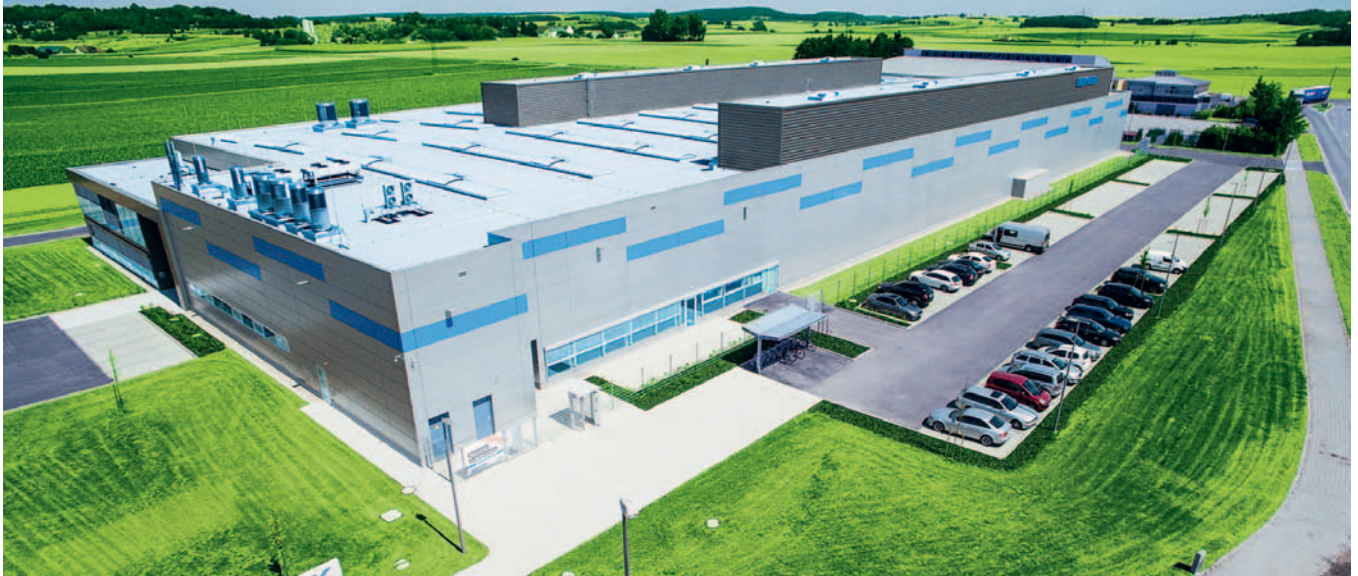
Jüngster Neuzugang im Boysen-Produktionsnetzwerk. In Kösching werden Abgasanlagen für den neuen Audi A4 gefertigt
